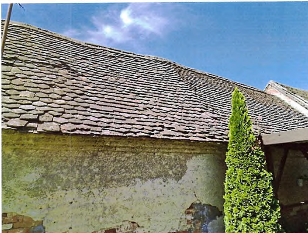
Obrázok 5: Opadaná omietka, nutné vysušenie muriva a opätovné omietnutie. Padajúce škridly ohrozujú zdravie.
