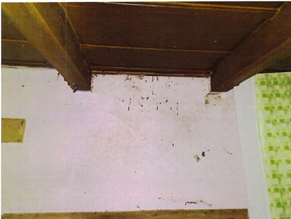
Obrázok 9: Vytrhnutý nosník zo steny vpravo aj vľavo.
